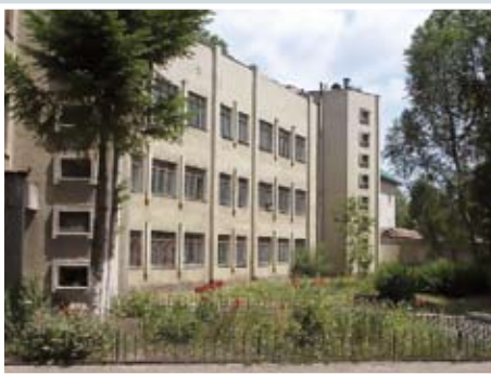
Будівля інженерно-лабораторного корпусу
