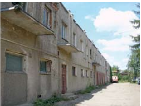
Двоповерхова будівля керносовища
