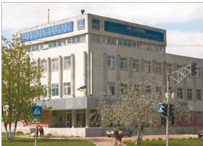
ПрАТ «ТК Стиль» (на фото: адміністративно-виробничий корпус) – динамічне підприємство з повним виробничим циклом
