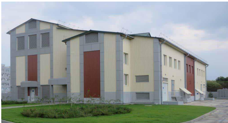
GIS substation 110 кV “Pribuzka”
